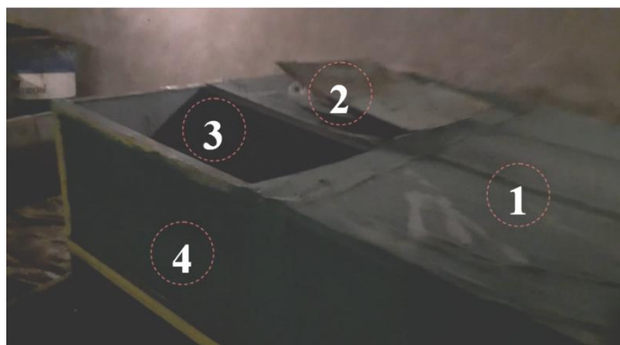
Рисунок 5 – для герметизации стыков соединения поверхности биореактора облицованием термо и гидростойким материалом «Изостекло» факельным наплавлением
