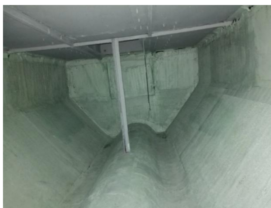
Рисунок 6 – Биореактор готовый для загрузки после проведения реставрационных работ по герметизации термо и гидростойким материалом «Изостекло» наплавлением и покраской гидротермостойкой краской
