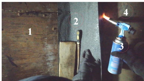
Рисунок 3. Герметизация стыка соединения боковой стены с донной частью биореактора облицованием термо и гидростойким материалом «Изостекло» факельным наплавлением
